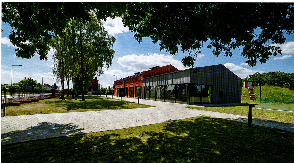
FOT. 2 SUW Zaborowo po zrealizowanej modernizacji
