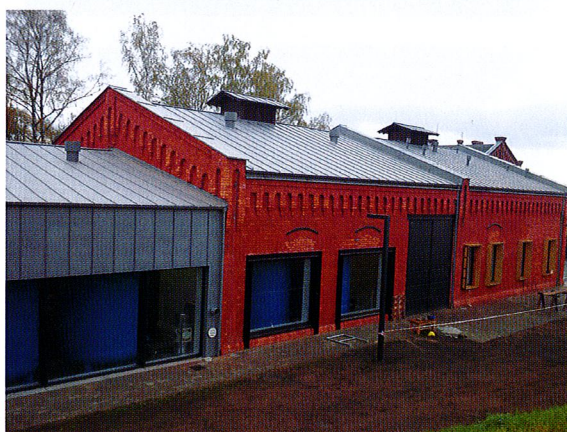
FOT. 4 Budynek SUW Zaborowo w końcowym etapie modernizacji
