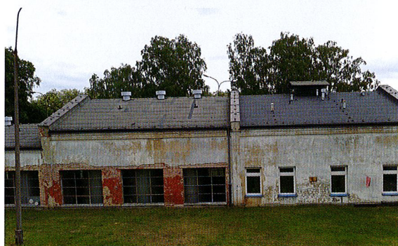
FOT. 3 Budynek filtrów oraz części socjalnej SUW Zaborowo przed modernizacją (początek roku 2013)
