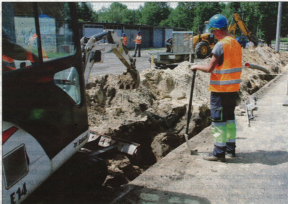
Szybko postępują prace zlecone przez MPWiK przy ul. 55 Pułku Piechoty w Lesznie.
