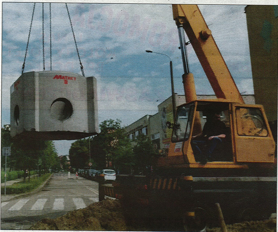
Roboty na ul. Westerplatte w Lesznie.
